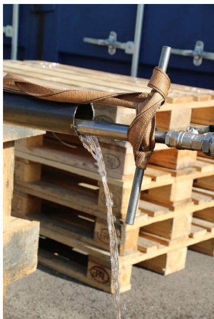
Figur 3-1 Läckage ut från stålröret med ej fullt uppspänd manschett-pack.
