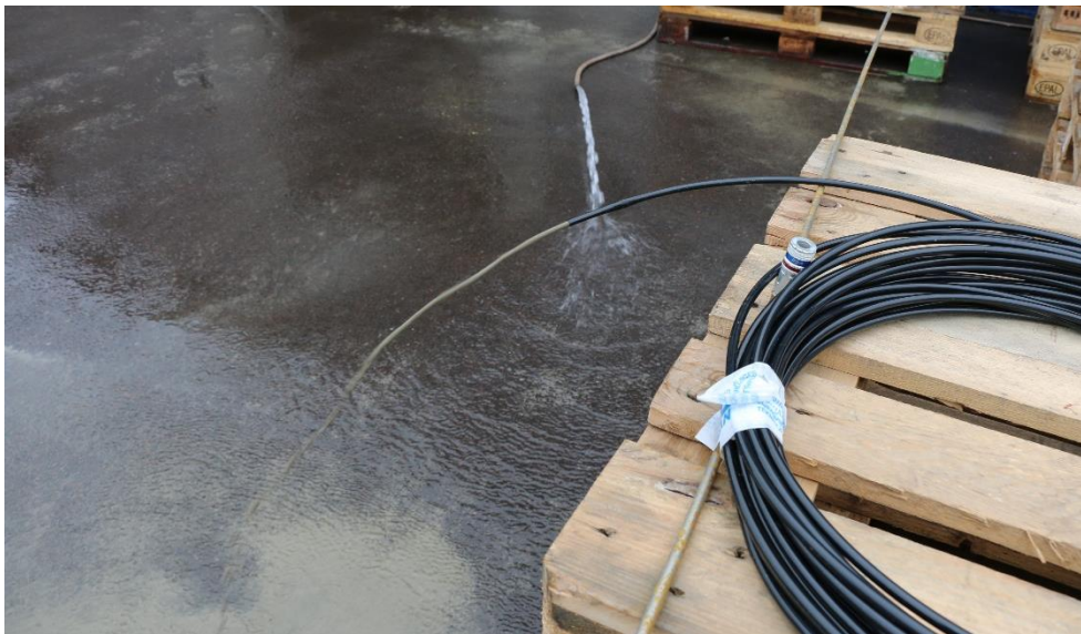
Figur 4-12. Urspolning av injektionsblandning efter ca 2 minuters spolning.
