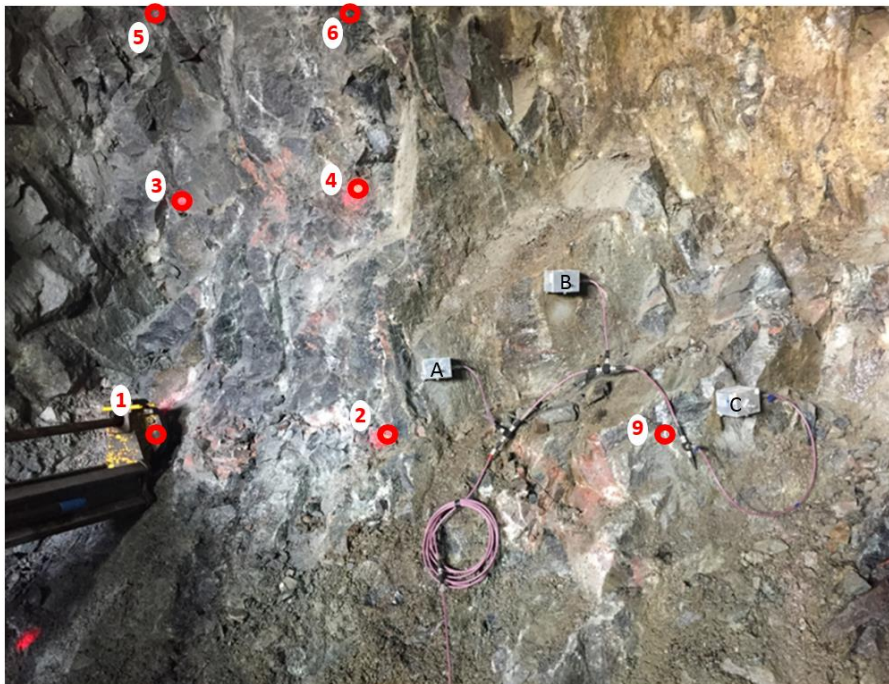
Figur 2 mätupställning, 3 triaxiella givare syns i bild (A (mp 4800), B (mp 10410) och C (mp 11580)). De platser där borrning utfördes har märkts ut med röd färg. Hålen som använts i analysen är 2 och 9 som är utmärkta i bilden.
