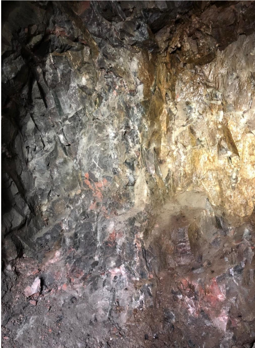
Figur 3. Bild över tunnelfront. I höger av bilden syns "blankslaget" med rostfärgad avlagring. Till vänster syns det mer blockrika bergmassan samt det skiviga berget med sprickor parallellt med tunnelriktningen.
